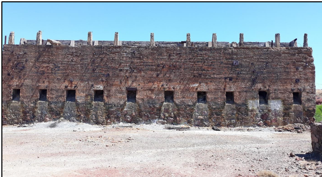
Descarregador de Minério
