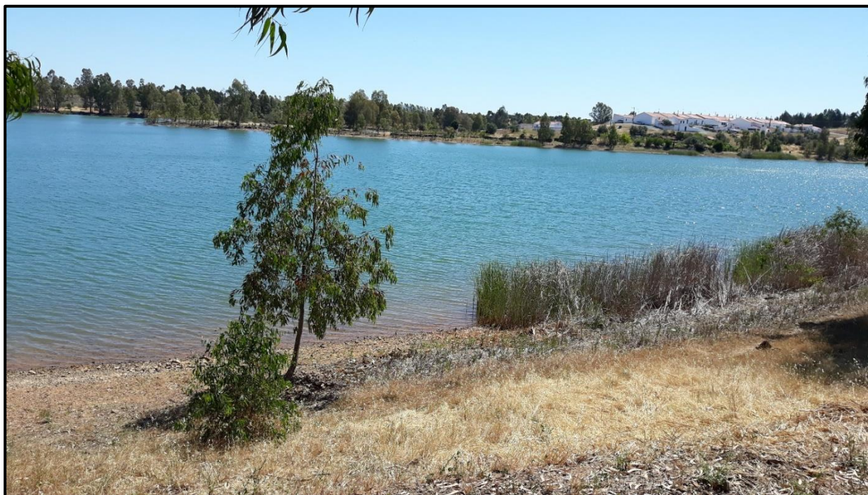
Vista Geral da Barragem da Tapada Pequena
